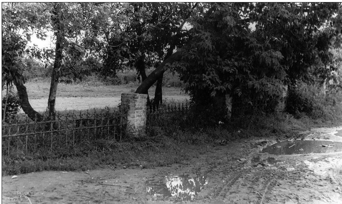
Комплекс центральной части деревни, XIX – начало XX вв., ограда Троицкой церкви, вид с северо-запада (фото 1980 г.).
