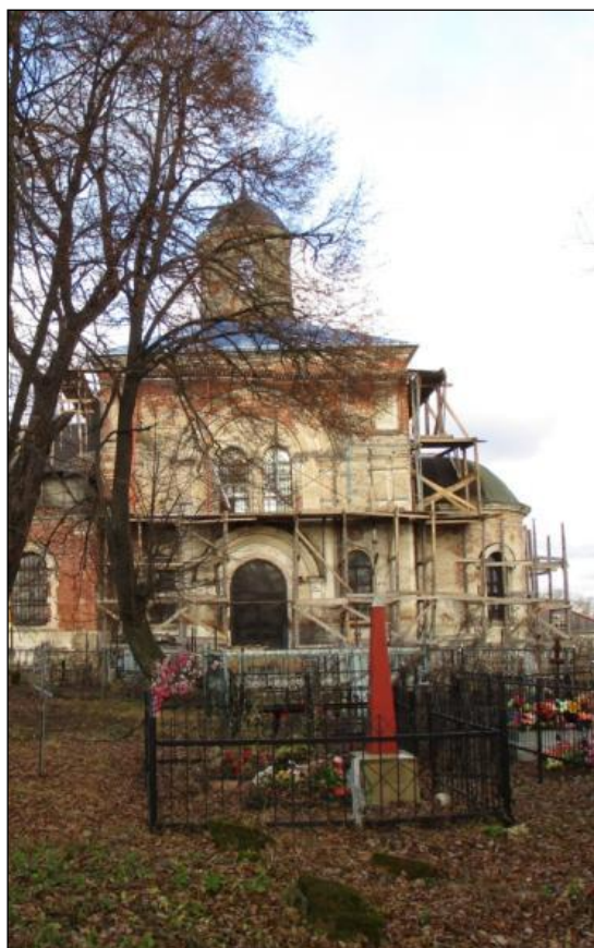
южный фасад (фото 2015 г.).
