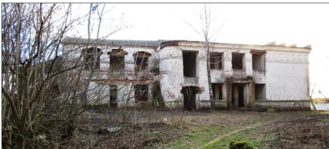
Северный фасад (фото 2015 г.).
