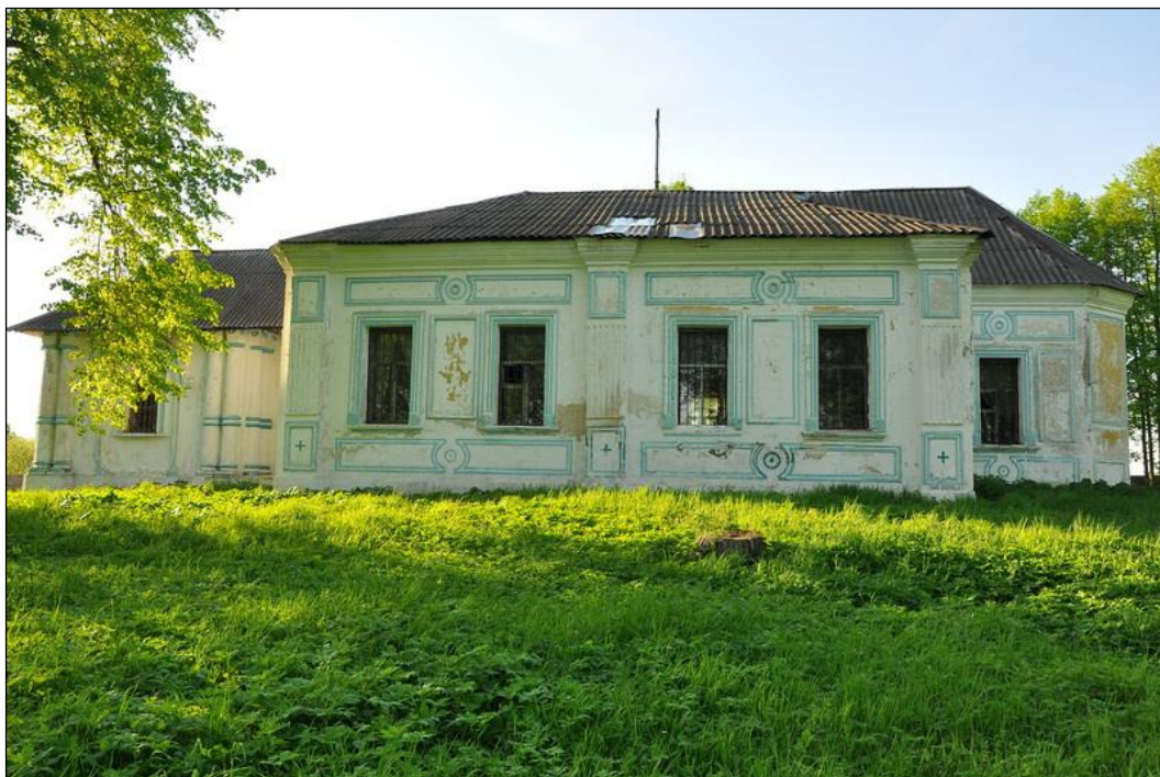
Южный фасад (фото 2010 г.).
