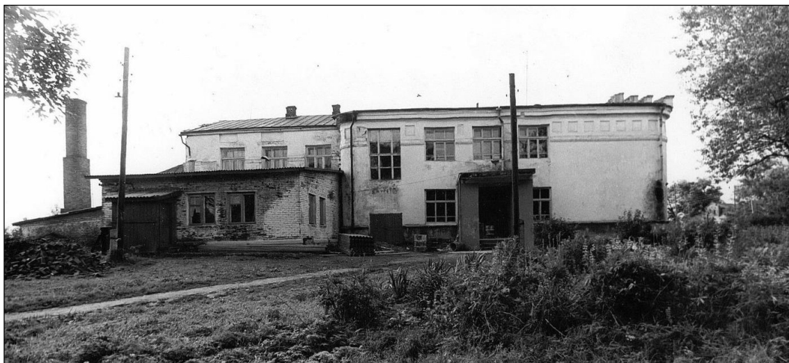
Северный фасад (фото 1980 г.).
