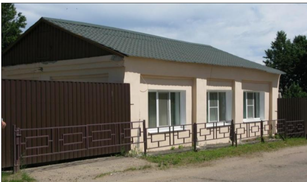
Общий вид с северо-запада (фото 2013-2014 гг.).
