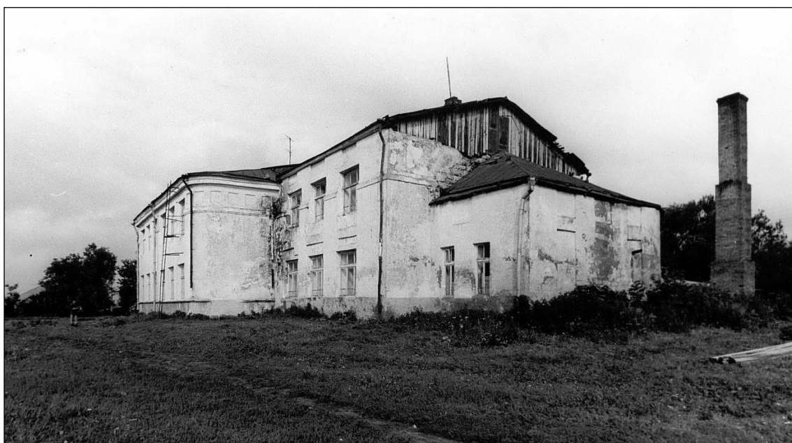
Общий вид с юго-востока (фото 1980 г.).
