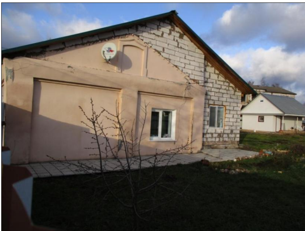
Южный фасад (фото 2015 г.).
