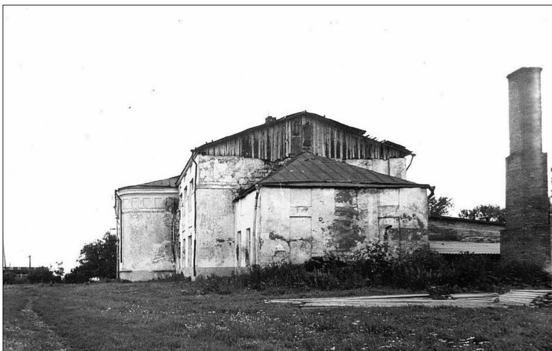
Деревня Калицино. Комплекс центральной части деревни, XIX – начало XX вв., Троицкая церковь, вид с востока (фото 1980 г.).
