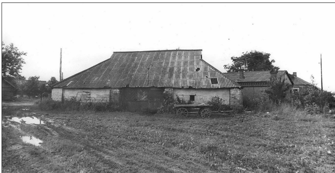
Комплекс центральной части деревни, XIX – начало XX вв., конюшня, общий вид с северо-востока (фото 1980 г.).
