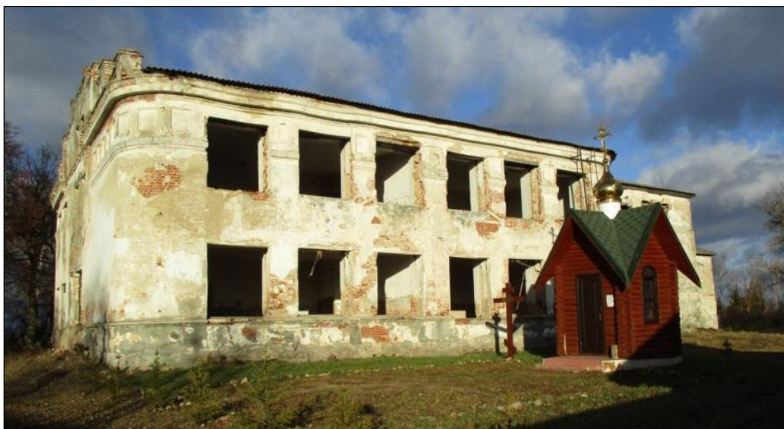
Южный фасад (фото 2015 г.).
