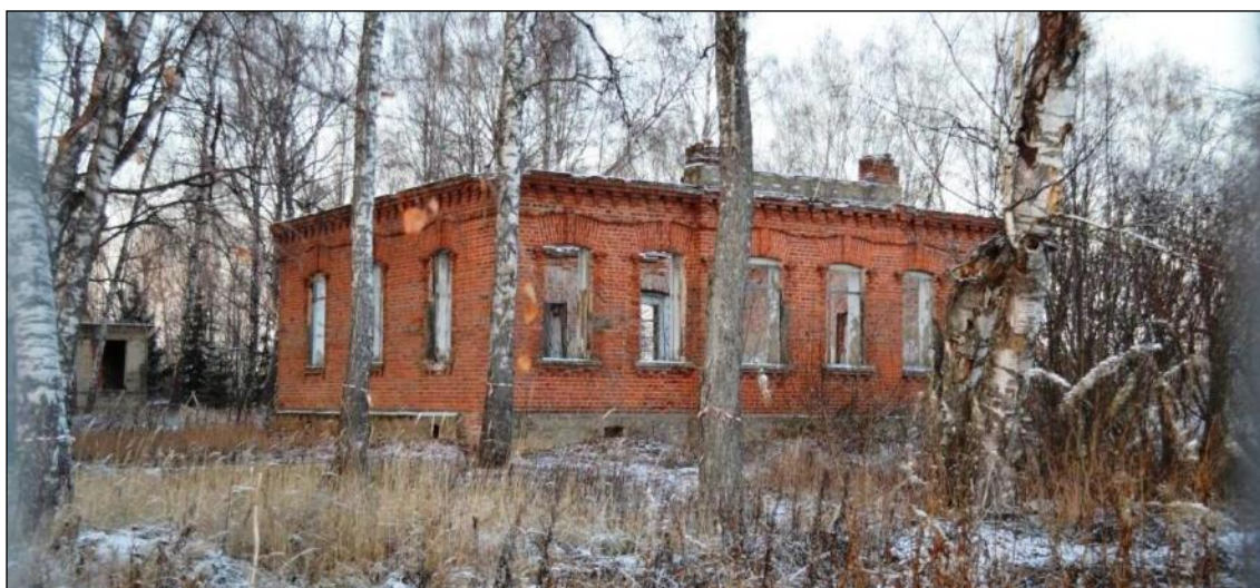
Вид с юго-востока (фото 2010-2015 гг.).
