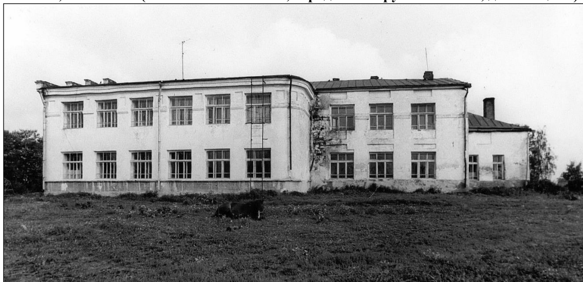
Вид с юга (фото 1980 г.).
