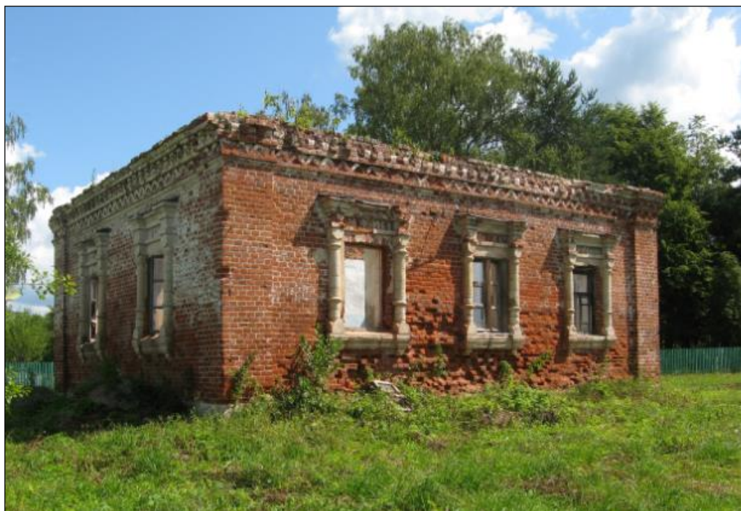
Северный фасад (фото 2000-х гг.).
