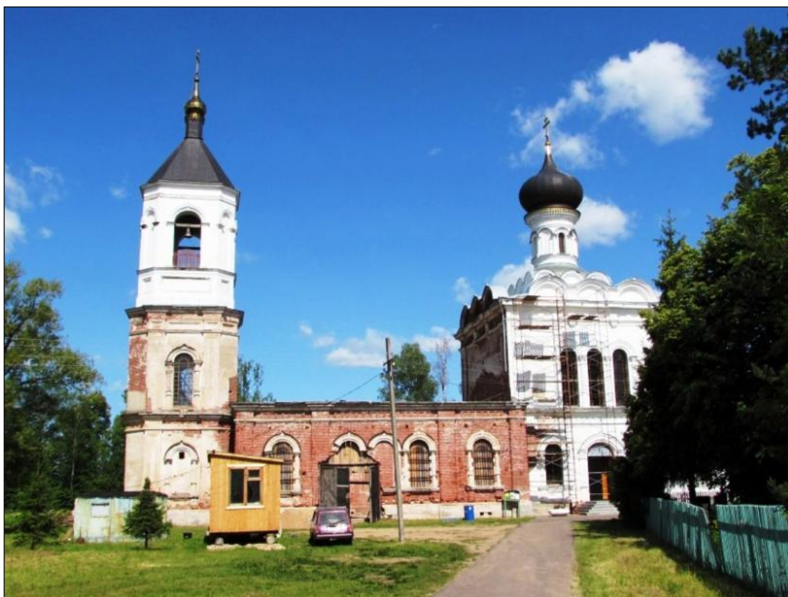
общий вид с юга (фото 2015 г.)
